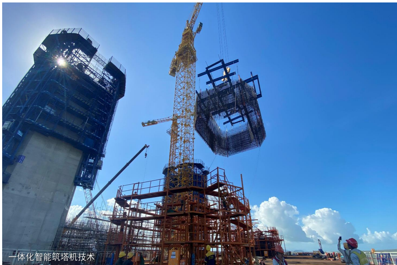
深中通道筑塔机
