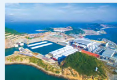
深中通道钢壳混凝土沉管预制关键技术
