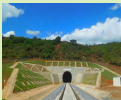
肯尼亚内罗毕至马拉巴铁路一期项目
