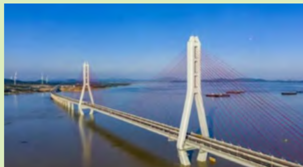
都昌至九江高速公路鄱阳湖二桥
