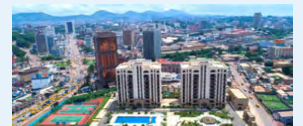
综合开发类优秀项目——喀麦隆雅温得城市综合体一期
