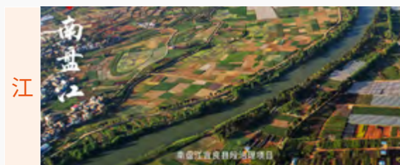
南盘江宜良县段治理项目
