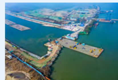
大型内河沉管隧道建造关键技术
