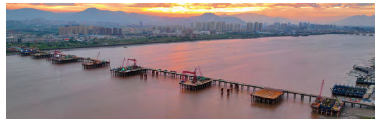
中国路建温州永宁大桥
