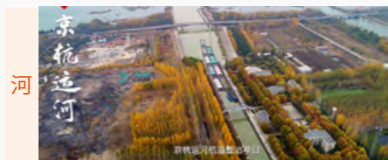
京杭运河航道整治项目
