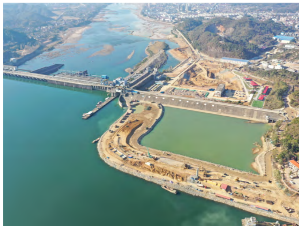
万安枢纽二线船闸
