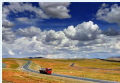
青藏高海拔多年冻土高速公路建设关键技术
