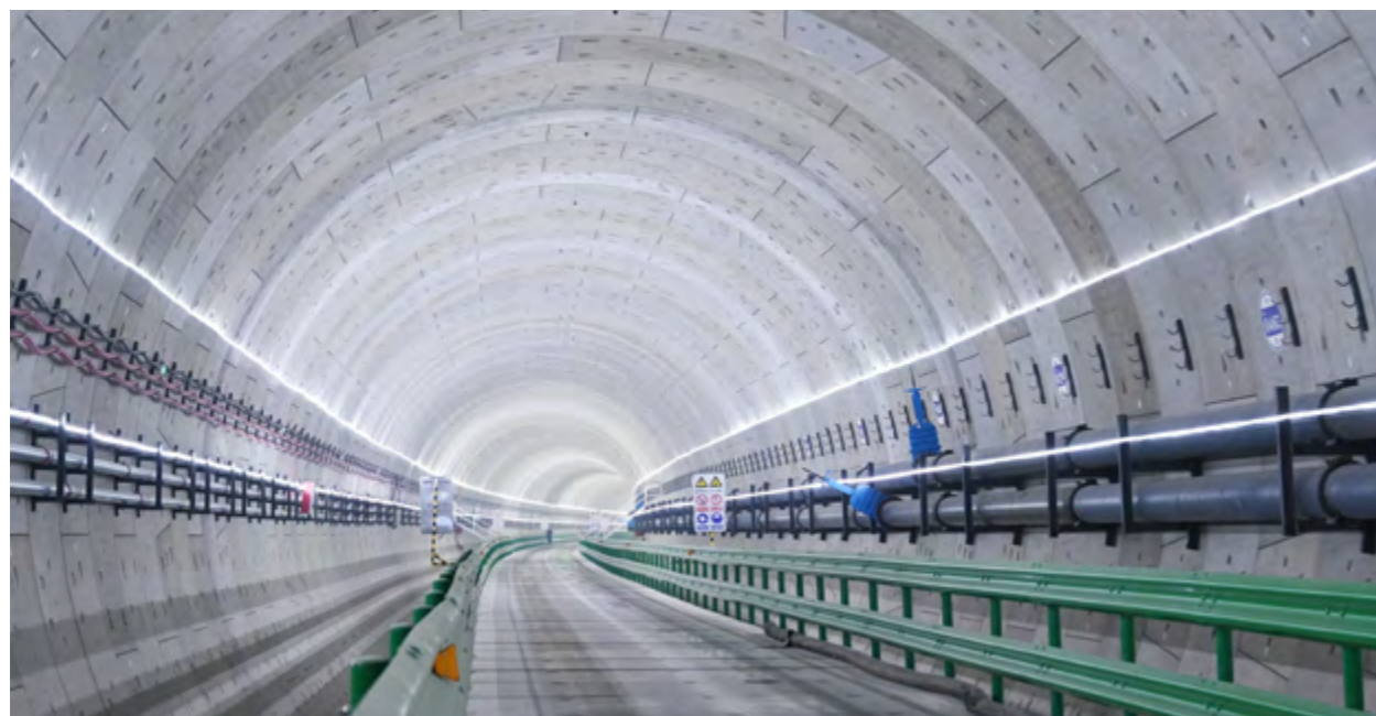
北京东六环改造工程东线隧道
