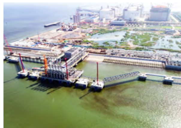
北燃天津南港 LNG 项目配套码头工程
