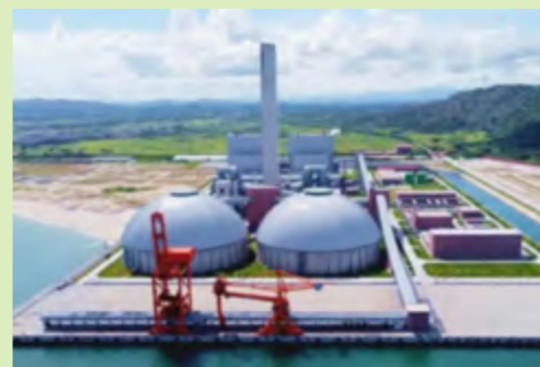
广东陆丰甲湖湾电厂新建工程配套码头工程
