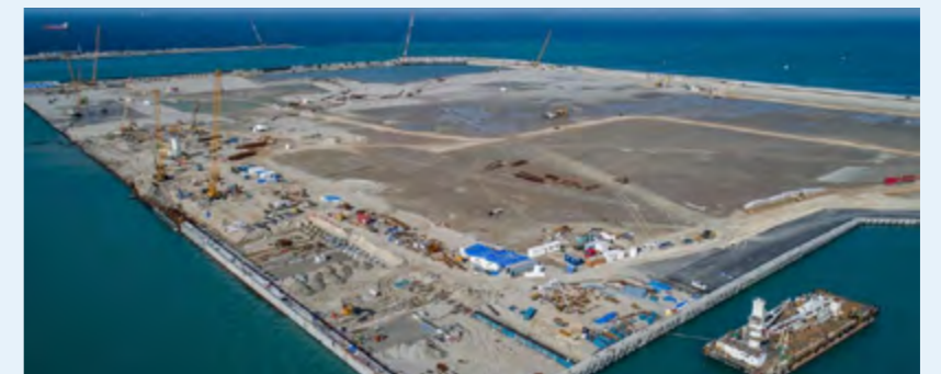
机场/港口类最佳项目——以色列阿什杜德港
