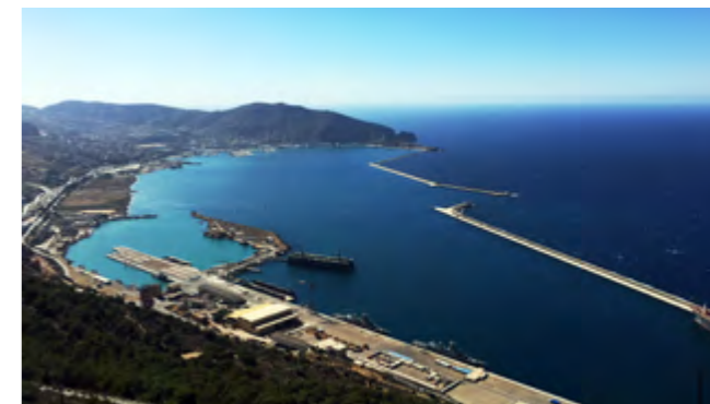
奥兰港集装箱码头扩建工程
