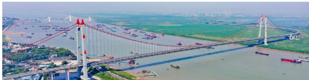
湖南省临湘至岳阳高速公路洞庭湖大桥
